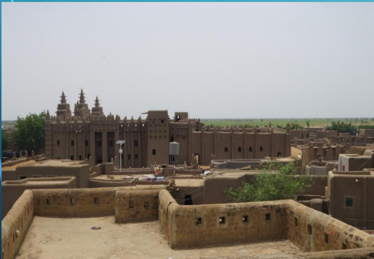
Photo N° 1: Djenné: vue sur la Grande Mosquée – Photo H.A. DIOP – Août 2017
