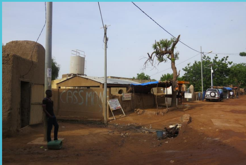
Photo N° 6: Djenné: vue sur un bâtiment administratif construit en ciment – Photo H.A. DIOP – Août 2017
