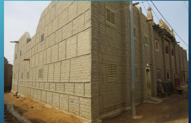
Photo N° 4: Djenné: vue sur une concession avec la façade habillée en pierre qui se dégrade – Photo H.A. DIOP – Août 2017
