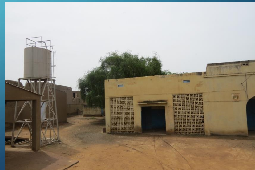
Photo N° 9: Djenné: Djenné: vue sur un bâtiment administratif construit en ciment – Photo H.A. DIOP – Août 2017
