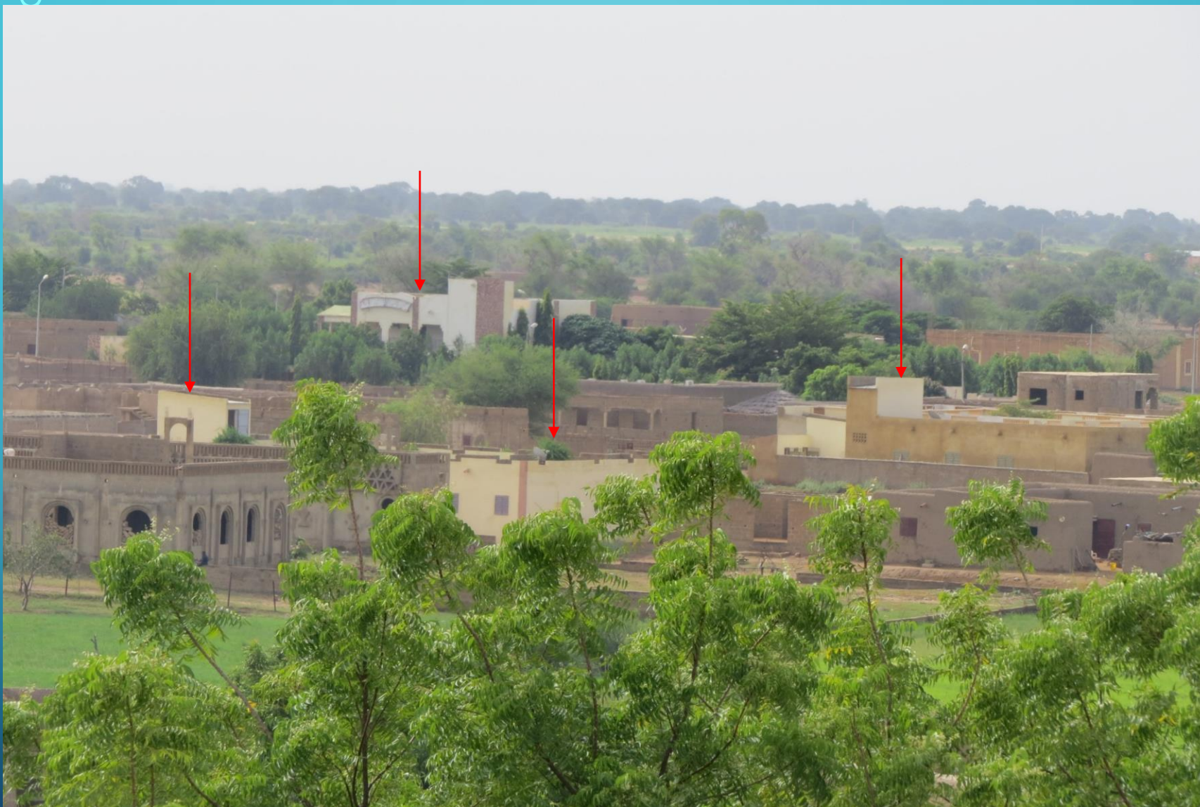
Photo N° 10: Djenné: vue sur des habitations construit en ciment avec des peintures personnalisés – Photo H.A. DIOP – Août 2017
