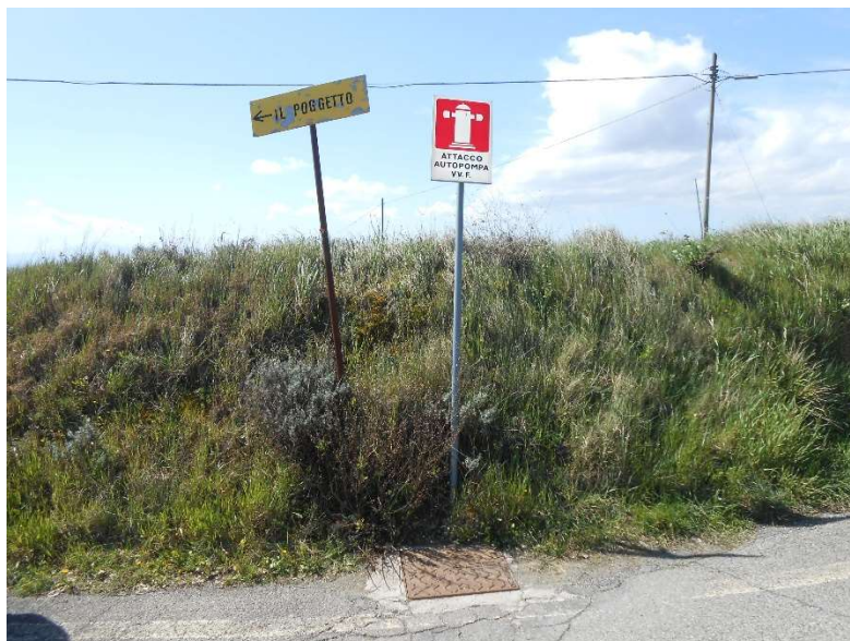
Immagine n. 13 – Dispositivo di presa localizzato in loc. Fossatello-Colonnetta di Prodo, area agricola, nei pressi della Viabilità ordinaria - Attacco di presa UNI 45.
