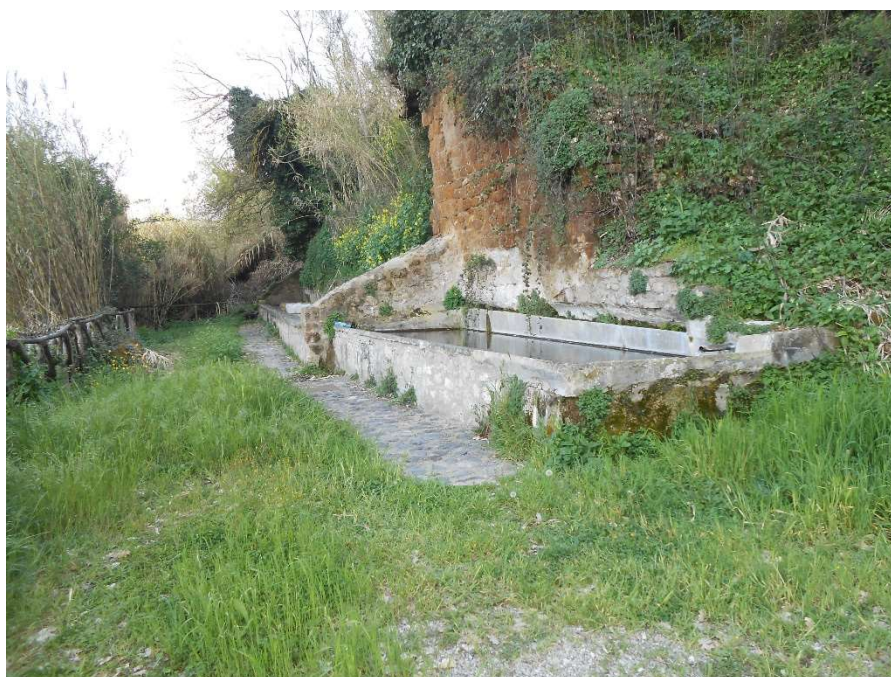
Immagine n. 6 – Loc. Cannicella (Comune di Orvieto). Accessibile con Fuoristrada– Stimato in circa 25 mc complessivi lo stoccaggio utile delle vasche.
