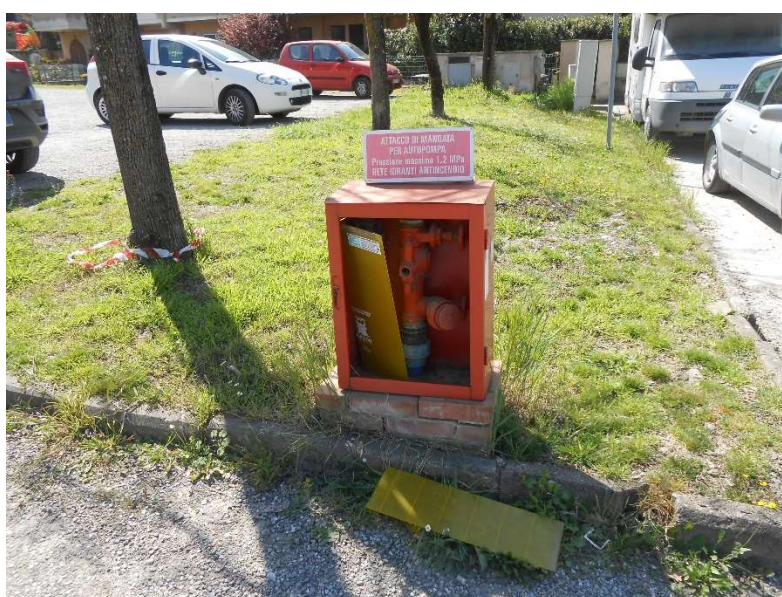
Immagine n. 10 – Dispositivo di presa localizzato nella Fraz. di Ciconia, area urbana, nei pressi della sala Agorà - Attacco di presa UNI 70.
