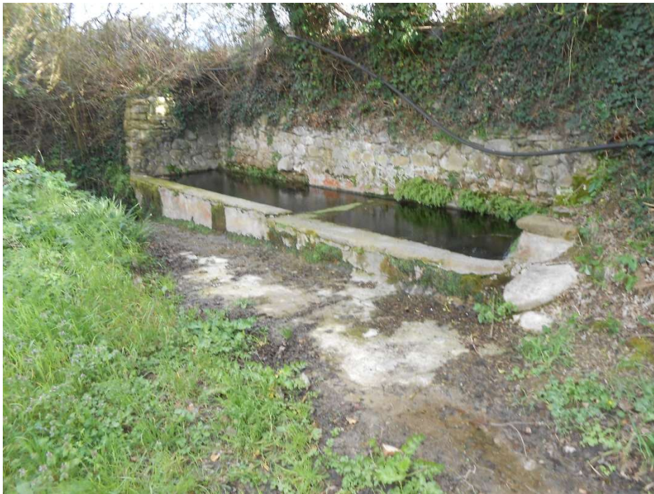
Immagine n. 3 - Pian del Vantaggio (Comune di Orvieto). Accessibile con Fuoristrada– Stimato in circa 7-8 mc complessivi lo stoccaggio utile delle vasche.
