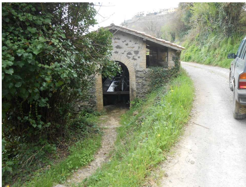
Immagine n. 9 – Comune di Porano. Accessibile con fuoristrada – Stimato in circa 10 mc complessivi lo stoccaggio utile delle vasche.
