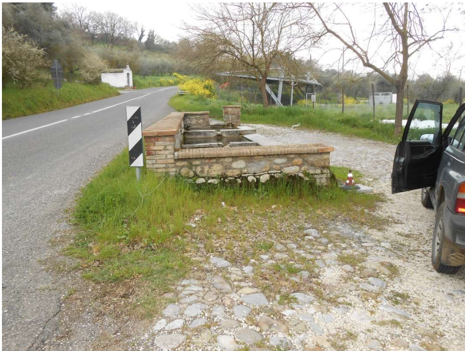
Immagine n. 2 – Loc. Monterubiaglio (Comune di Castel Viscardo). Accessibile con tutti i mezzi – Stimato in circa 10 mc complessivi lo stoccaggio utile delle vasche.
