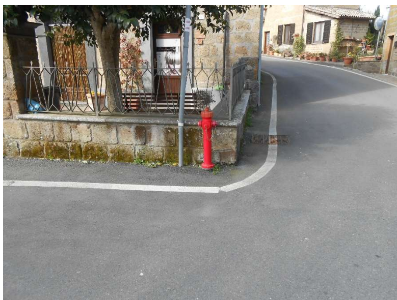
Immagine n. 14 – Dispositivo di presa localizzato in loc. Fraz. Torre San Severo nei pressi del centro storico - Attacco di presa UNI 45.
