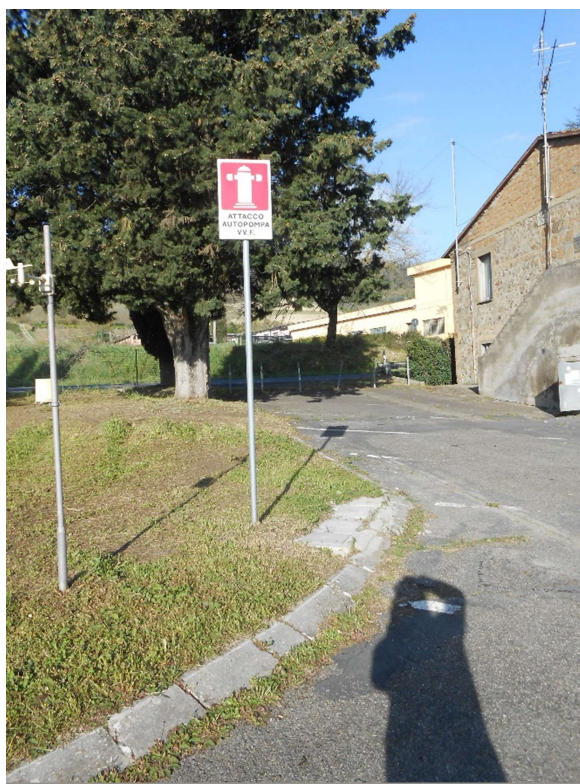
Immagine n. 9 – Dispositivo di presa localizzato in loc. Fontanelle di Bardano, area artigianale, nei pressi della Sede della Protezione civile di Orvieto - Attacco di presa UNI 70 + UNI 45.
