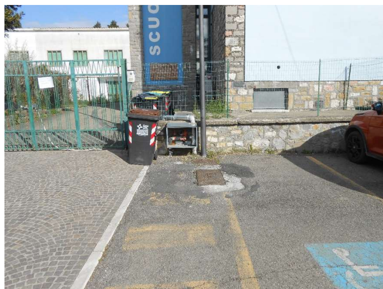
Immagine n. 8 – Dispositivo di presa localizzato in comune di Castel Viscardo, centro storico nei pressi della Scuola media. Attacco di presa UNI 70.
