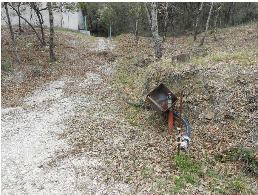
Immagine 4 – Dispositivo di presa localizzato in loc. Banditella, area agricola, nei pressi della Viabilità Ordinaria. Attacco di presa UNI 45.
