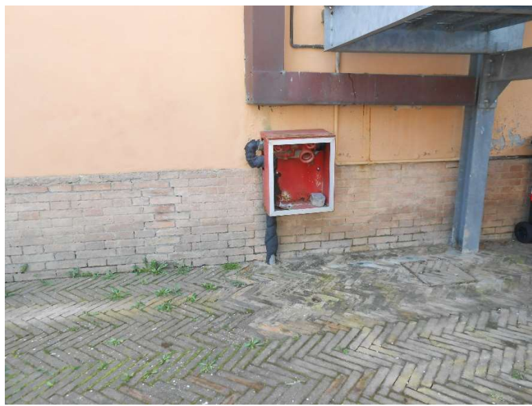
Immagine n. 7 – Dispositivo di presa localizzato in comune di Castel Viscardo, centro storico nei pressi dell'Edificio Comunale. Attacco di presa UNI 70.
